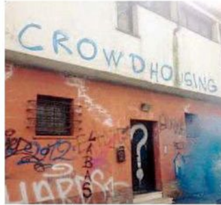
L'edificio in via Imerio
